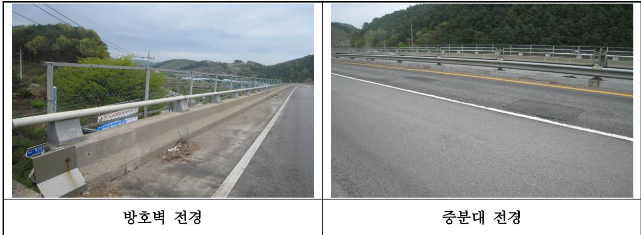
【사진 1.3.23】 방호벽 및 중앙분리대 전경
