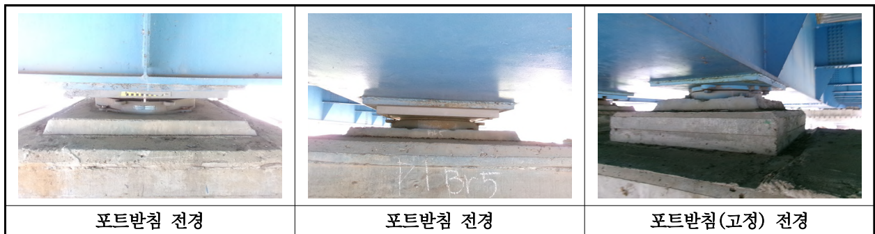
【사진 1.3.12】 교량받침 전경
