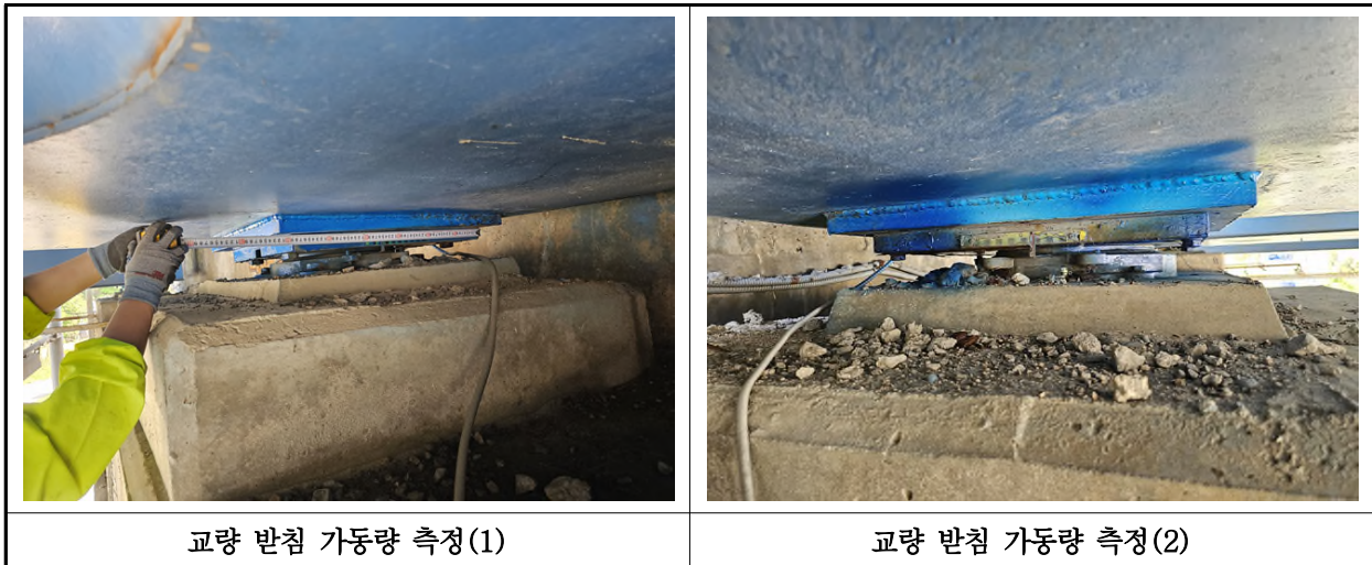
【사진 1.3.15】 교량받침 이동량 측정
