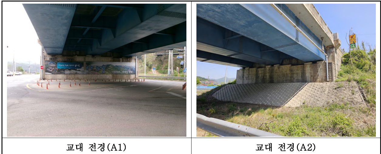
【사진 1.3.8】 교대 전경
