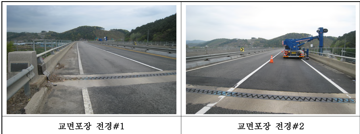
【사진 1.3.19】 교면포장 전경
