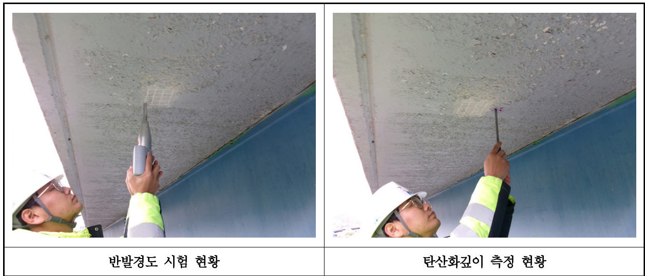
【사진 1.4.1】 콘크리트 내구성조사 현황
